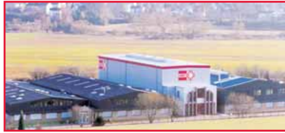
Hauptsitz der IBC Wälzlager GmbH im Industriegebiet Solms-Oberbiel
